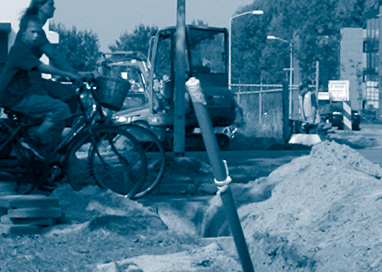
Aanleg glasvezel in Almere. (Bron: www.almerekennisstad.nl )
