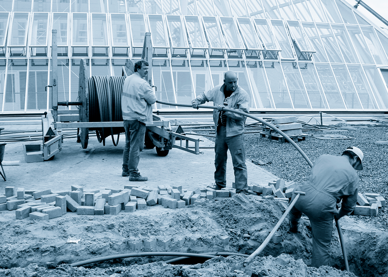
Aanleg glasvezel Leeuwarden. (Bron: ICT-Center Friesland)
